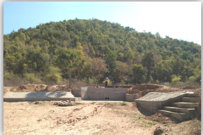
कार्य का नाम – नाला पथ उपचार कार्य व इनलेट निर्माण
